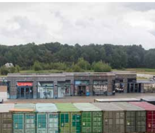
De straat in opbouw.
